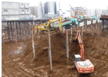
【新築工事の様子①】
