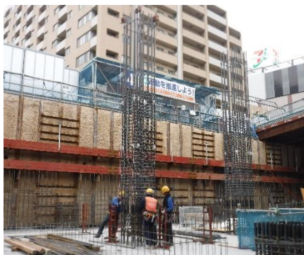
【写真①柱の鉄筋を組む様子】
