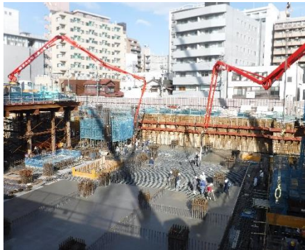
【写真②コンクリートを流し込む様子】
