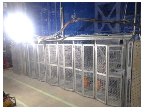
【写真③作業用エレベーターの設置状況（8月末撮影）】
