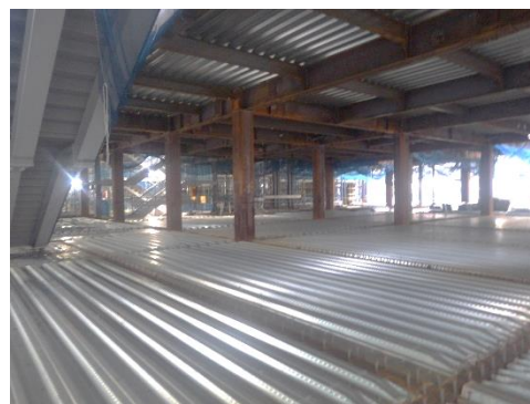
【写真②鉄骨造部分床デッキの様子（8月末撮影）】
